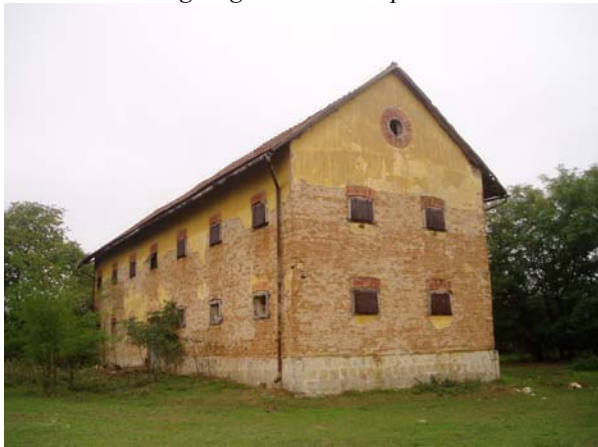
Gazdasági épület Görénypusztán
