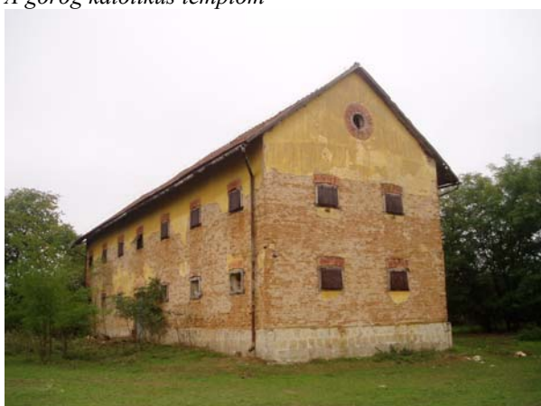
Gazdasági épület Görénypusztán
