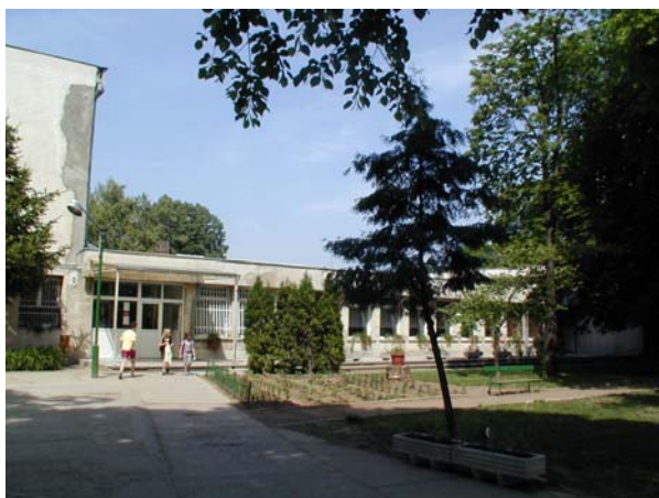
Szabolcs Vezér Általános Iskola és Diákotthon - Balkány, Kossuth út 5.
