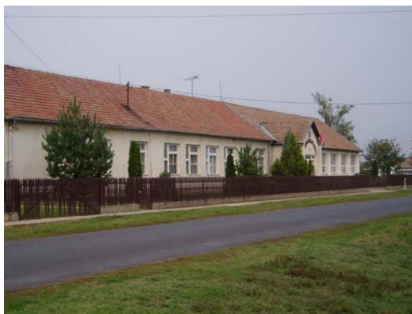
2. sz. Körzeti Általános Iskola, 4233.Balkány Béke-telep
