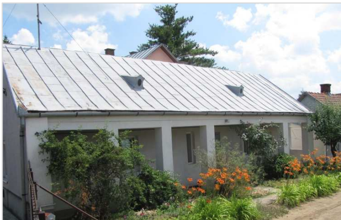
Oldalsó oszlopos tornácos épület
