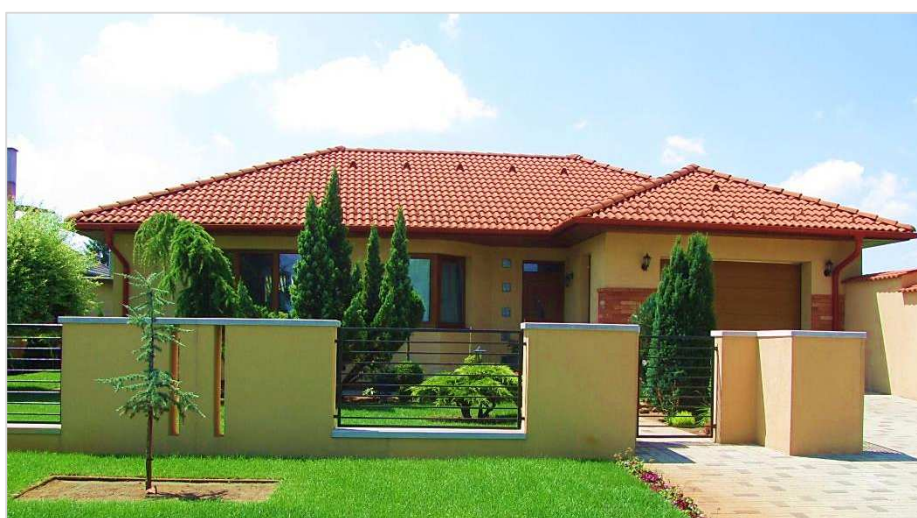
Részben tömör kerítés zártságát jól oldja az áttört kovácsoltvas kapu és a szemmagasságban lévő áttört kerítésbetét.
