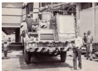
Kukoricaszárító építése a Balkányi Állami Gazdaságban (1988) Fotó: Molnár Sándor (a képen jobbról) saját archívuma
